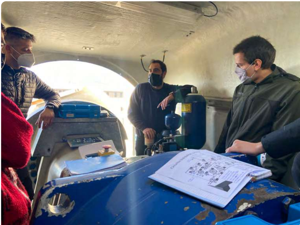
Prácticas en góndola, dentro del Curso de Técnico de Mantenimiento de Parques Eólico en 2021. Autor: AEE
